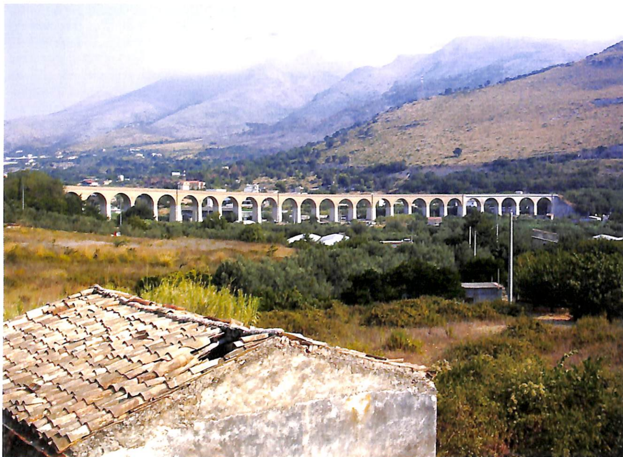
Il grande viadotto di Pontone detto dei "Venticinque Ponti"
